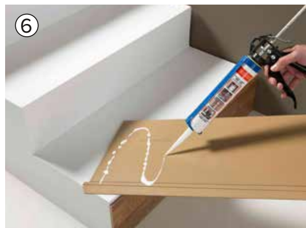
Encollez les 2 éléments assemblés (lame + nez de marche) puis fixez le tout sur la marche à l'aide de silicone.
